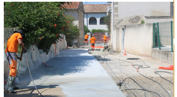
Pose du béton désactivé
