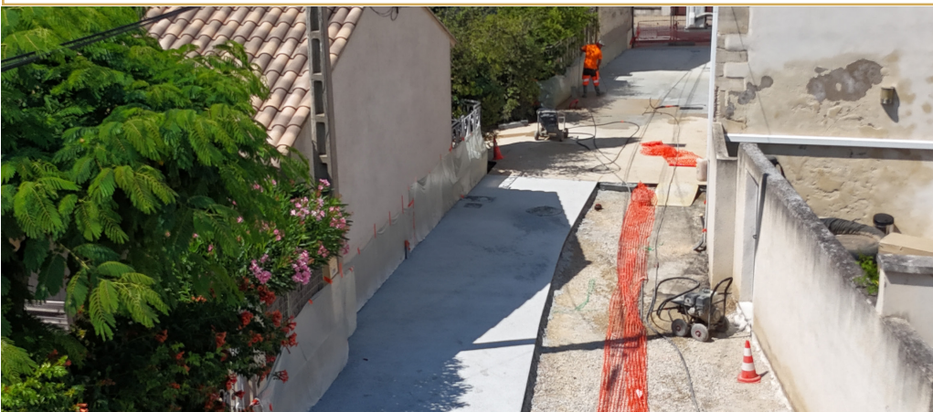
Travaux sur le Chemin de l'Arénier
