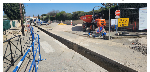
Travaux sur le Chemin de l'Arénier
