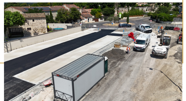
Le parking Bouveyron en cours de réaménagement
